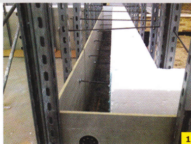
FOT. 1. Konstrukcja stabilizująca i szalunek tracony ściany zewnętrznej w technologii wykonania budynków energooszczędnych wykorzystującej od strony wnętrza płyty cementowo-drzazgowe; fot.: EKOBU
