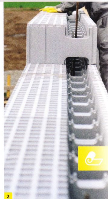
FOT. 1. Konstrukcja stabilizująca i szalunek tracony ściany zewnętrznej w technologii wykonania budynków energooszczędnych wykorzystującej od strony wnętrza płyty cementowo-drzazgowe; fot.: EKOBU
