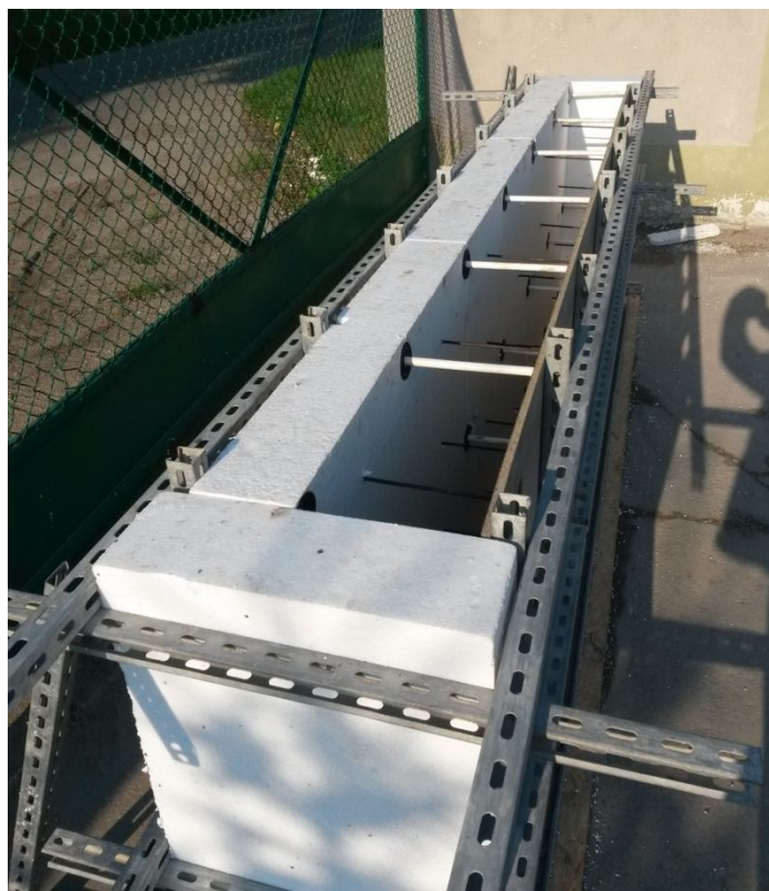
Fot. 7. Szalunek przeznaczony do wykonania testowego fragmentu ściany
