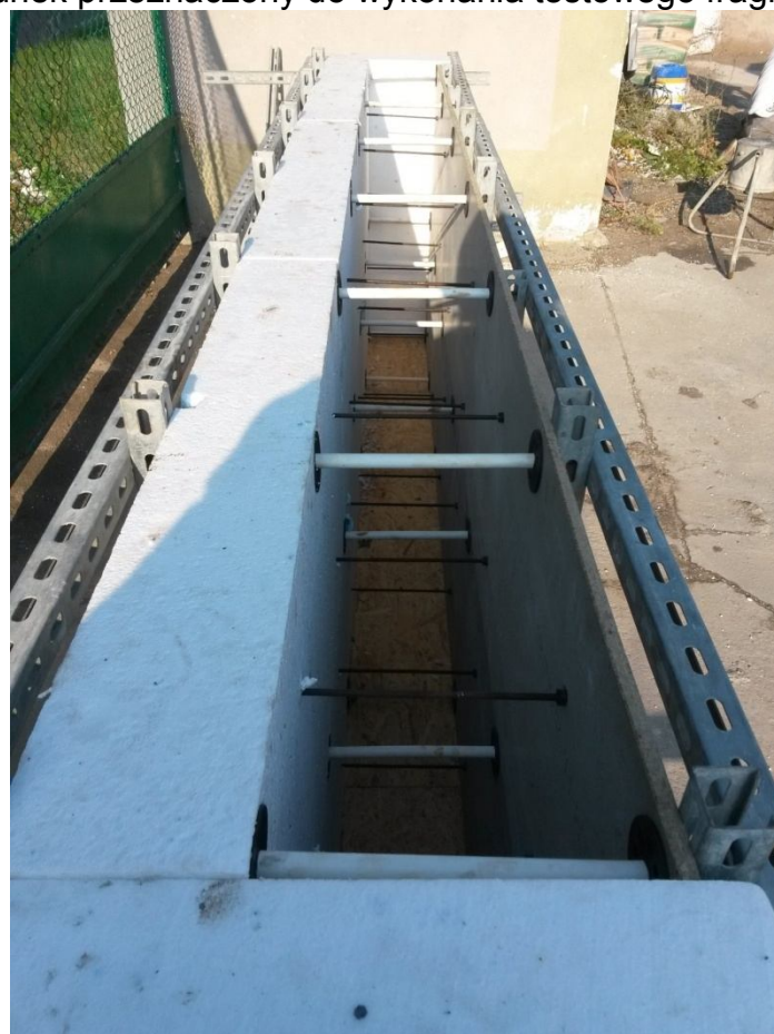
Fot. 8. Szalunek przeznaczony do wykonania testowego fragmentu ściany
