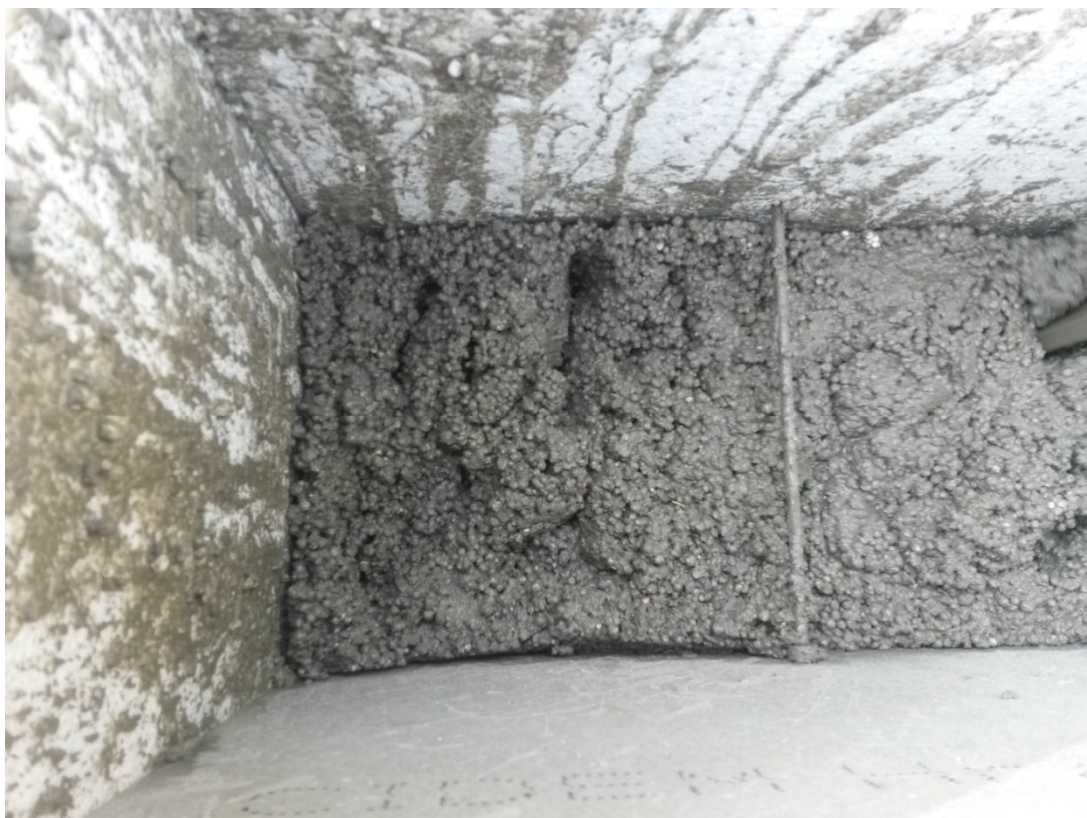
Fot. 9. Mieszanka betonowa w szalunku
