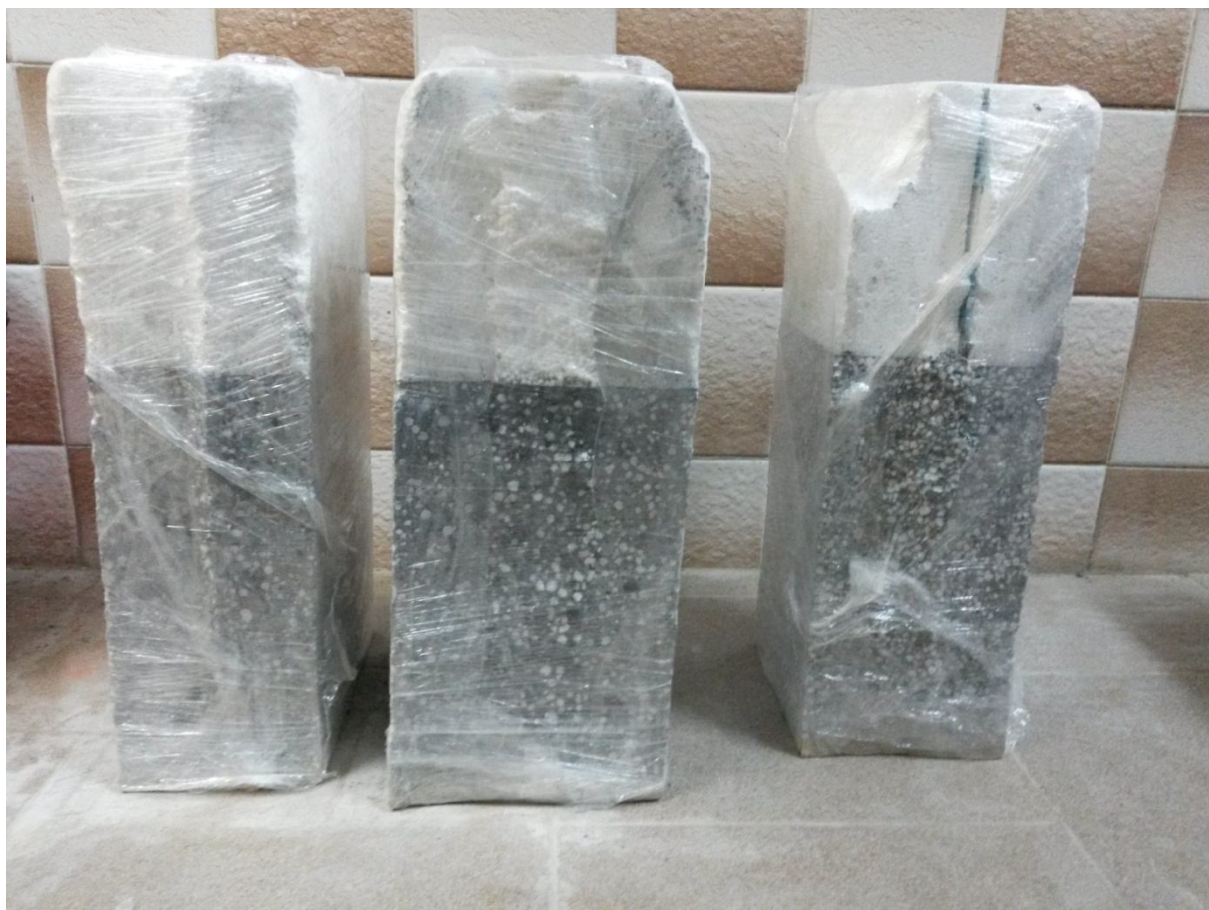
Fot. 1.12. Wycięte fragmenty testowego odcinka ściany
