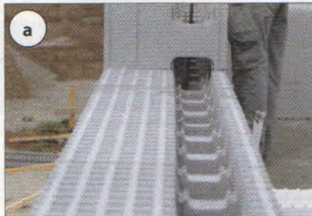
Fot. 1 | a) kształtki styropianowe systemu Izodom (www.izodom.pl), b) deskowanie tracone ściany zewnętrznej w technologii Ekobud [8]
