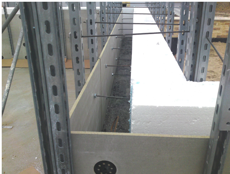
Rysunek 5.4 Widok konstrukcji stabilizującej i szalunku traconego
