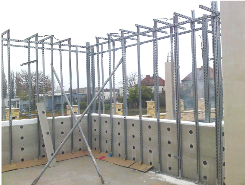
Rysunek 5.3 Widok konstrukcji stabilizującej i szalunku traconego
