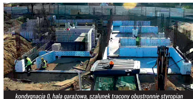
kondygnacja 0, hala garażowa, szalunek tracony obustronnie styropian
