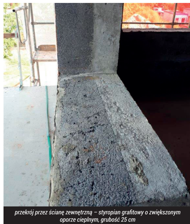
klejenie płyt styropianowych stanowiących jednocześnie zewnętrzny szalunek tracony
