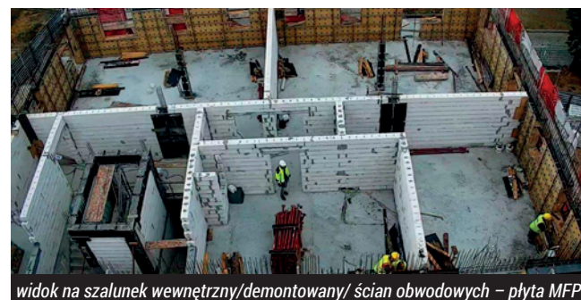
widok na szalunek wewnętrzny/demontowany/ ścian obwodowych – płyta MFP
